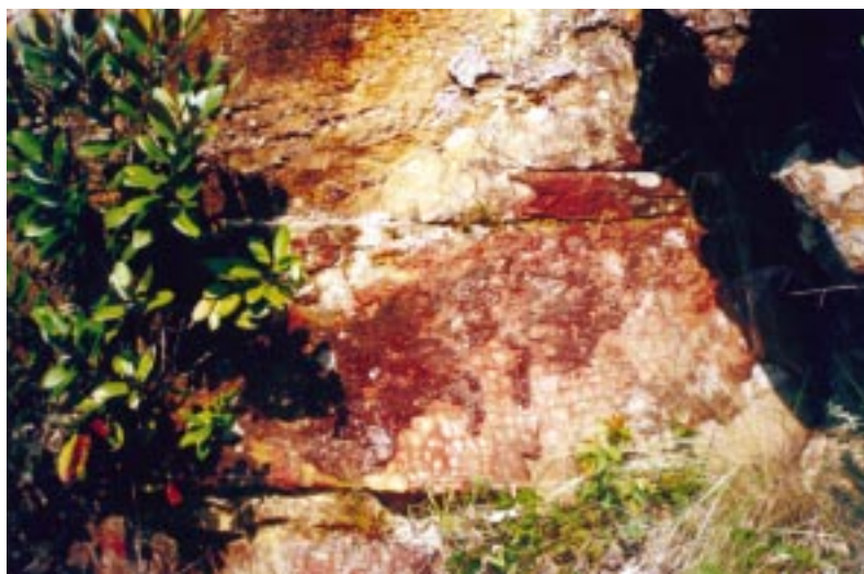
Parede polida formada por blocos com ângulos retos
